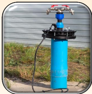
водопровод на улице 3,4%
